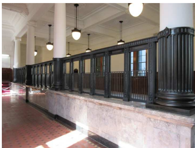
敦賀市立博物館（旧大和田銀行本店）1階 古写真や建物に残された痕跡をもとに 銀行カウンターを復元しました。
