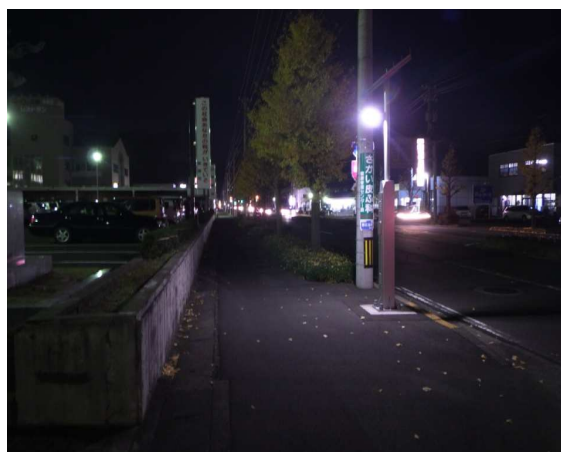
LED照明（市道中央沓見線）
