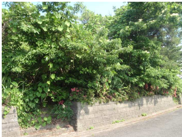
管理不良状態の空き地
